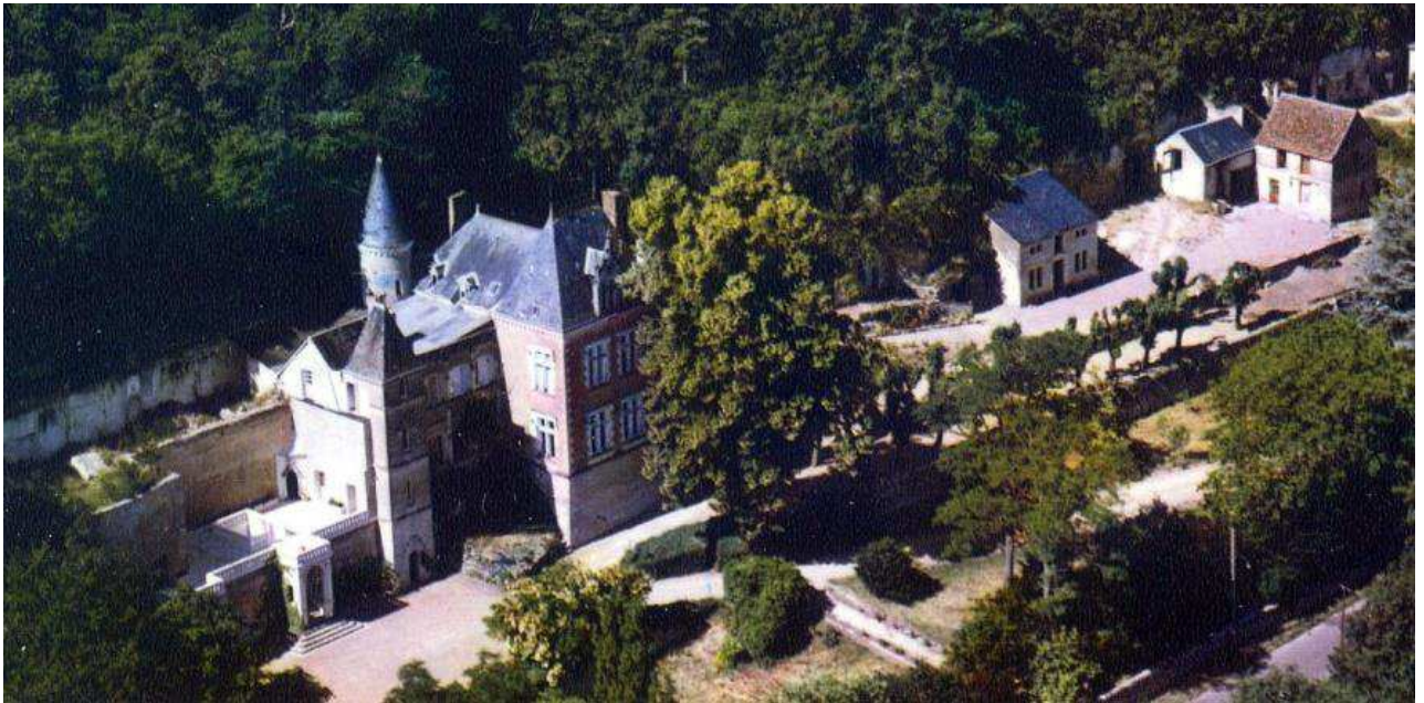
Le château du Plessis après les démolitions de l'aile du XVI e siècle.
