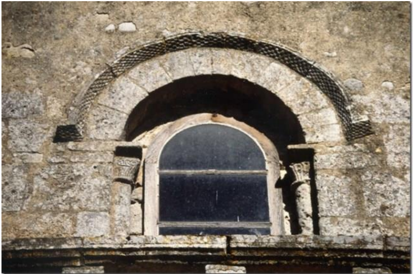
Baie occidentale de la façade de l'église de Saint-Georges-sur-Arnon (Indre ; 36) dont il manque le tore, le boudin supporté par les colonnes à chapiteau Photo Nicolas Huron
