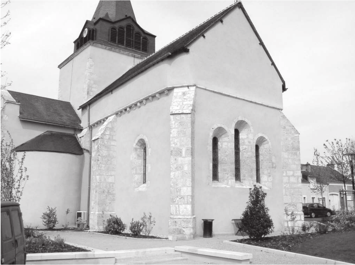
Le chevet de la fin du XIIème siècle. Le réhaussement de la toiture est postérieur.
