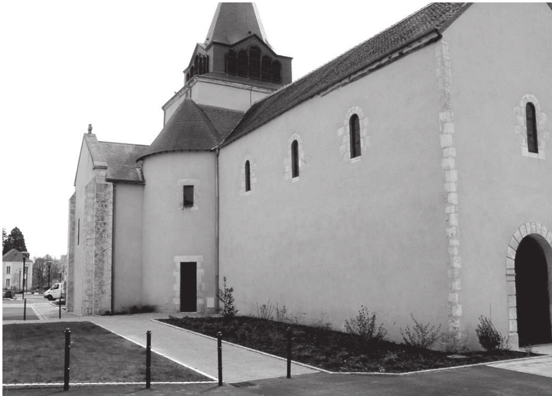
Transept nord, mur nord de la nef et façade ouest
