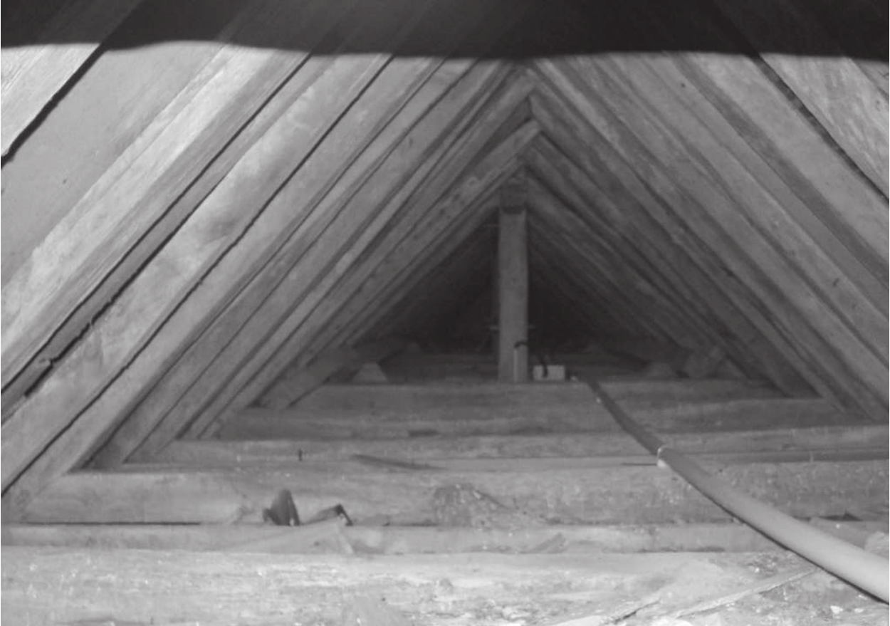
Charpente de la nef : 1835
