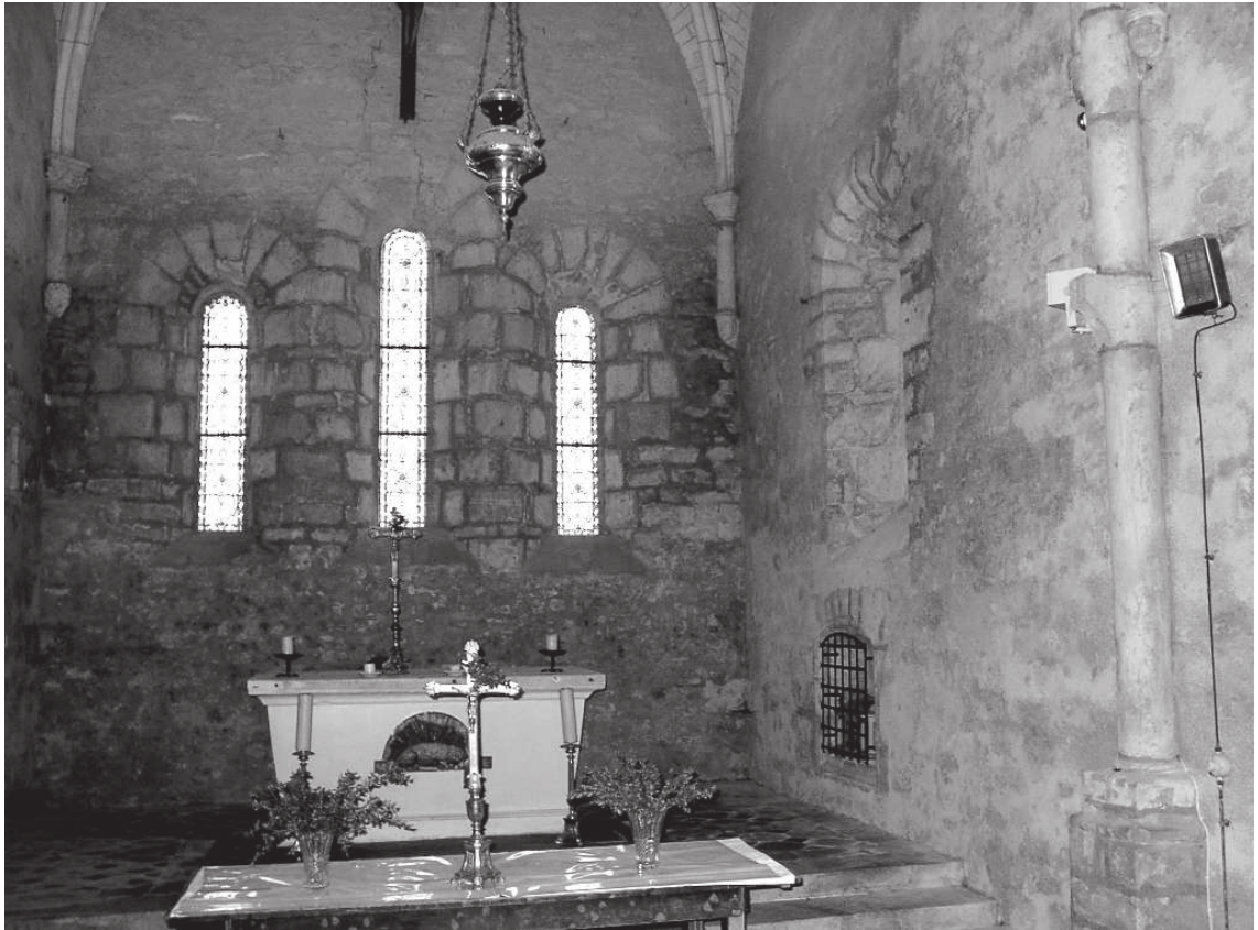
L'intérieur du nouveau chœur
