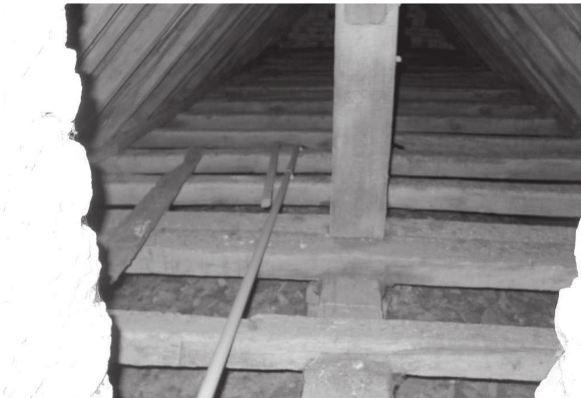
Charpente et voûte en pierre du chœur (comble vus du clocher)
