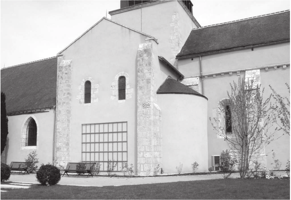
Le mur sud du transept sud renforcé de contreforts plats. L'absidiole de la chapelle sud.
