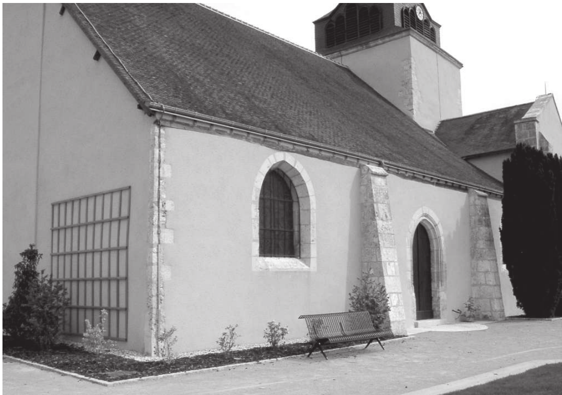
Le collatéral sud Les contreforts sont un rajout ultérieur
