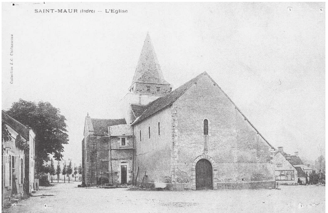
L'église pendant la construction de la tourelle (carte postale ancienne : Archives départementales de l'Indre)
