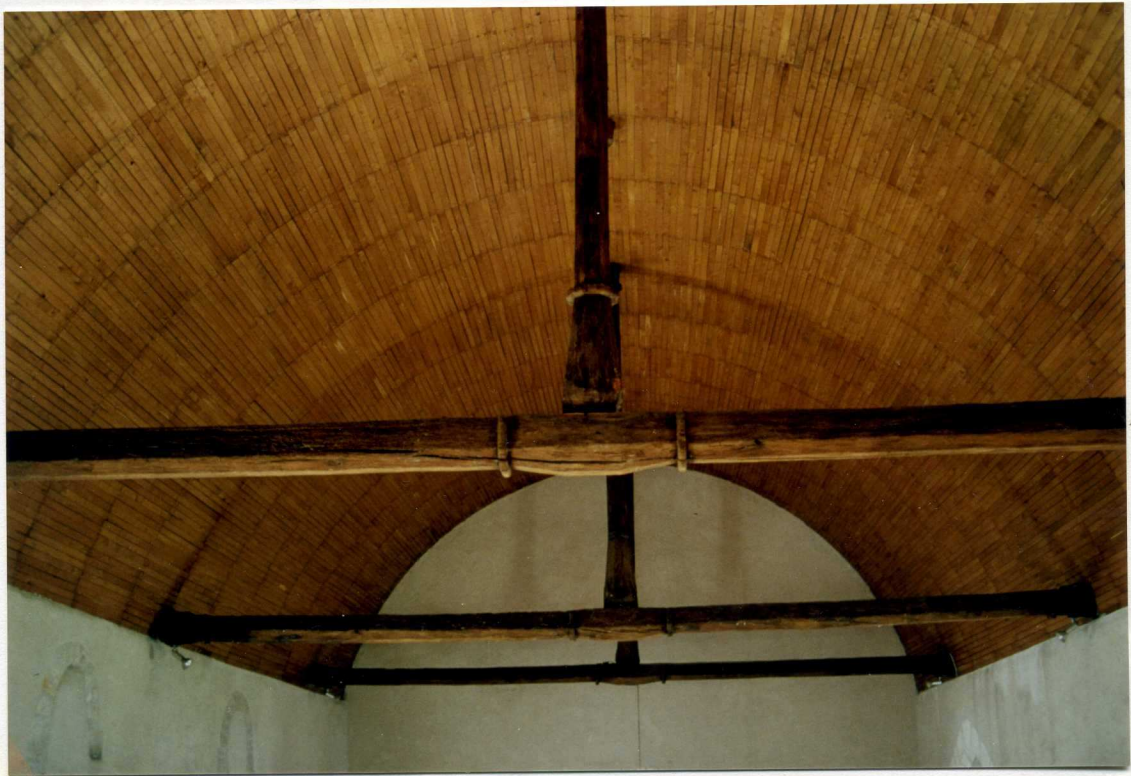
Entraits et poinçons apparents de la charpente du XVI° ou XVII° siècle
