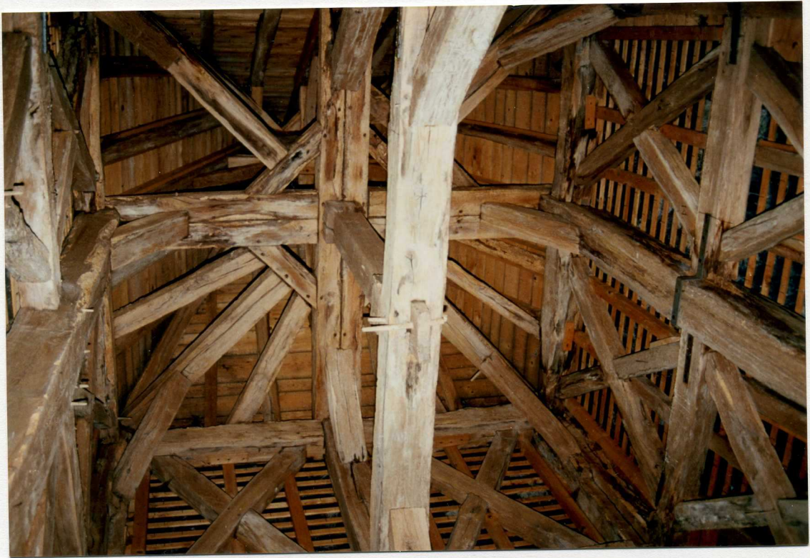
Charpente du clocher
