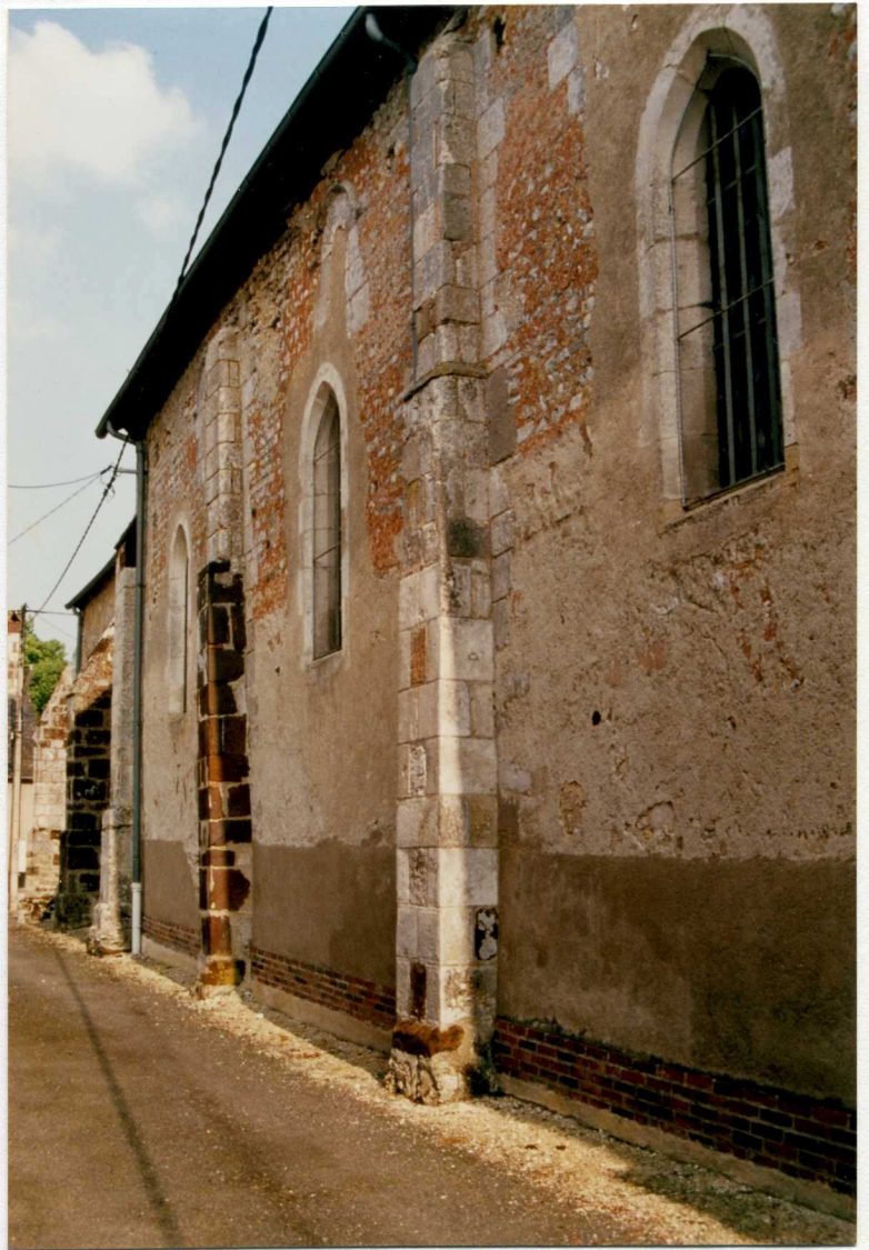
Mur nord de la nef traces des baies et contreforts romans et fenêtre de 1840
