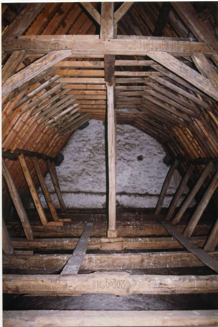
La charpente de la nef
