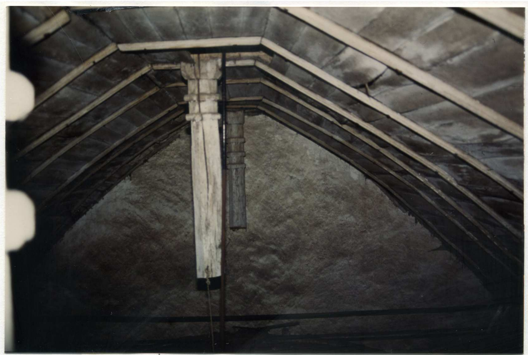
L'ancienne voûte en lambris de cette chapelle
