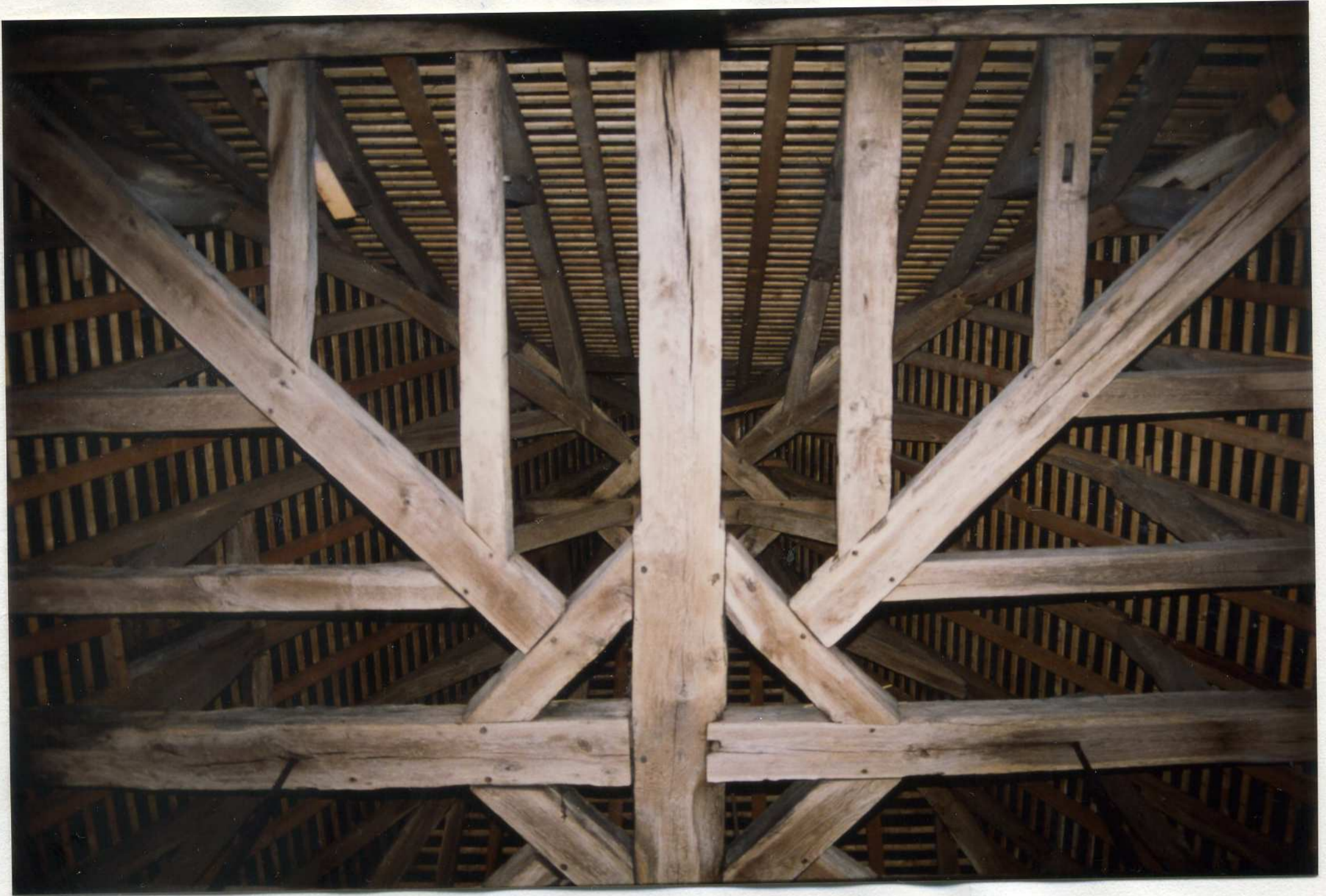
La charpente du clocher
