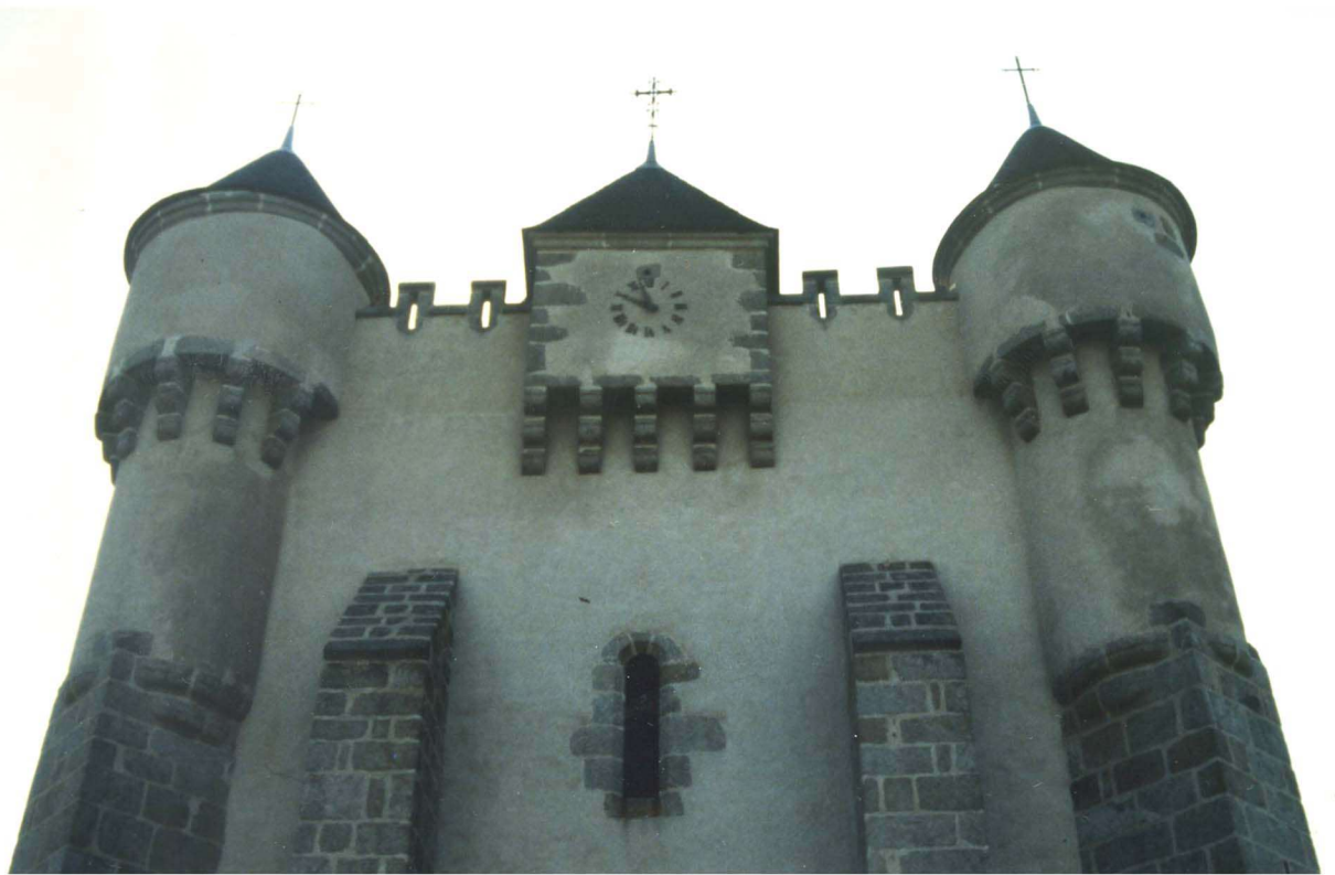
Le haut de la façade Ouest Une bretèche à machicoulis sur le chemin de ronde entre deux échauguettes à machicoulis
