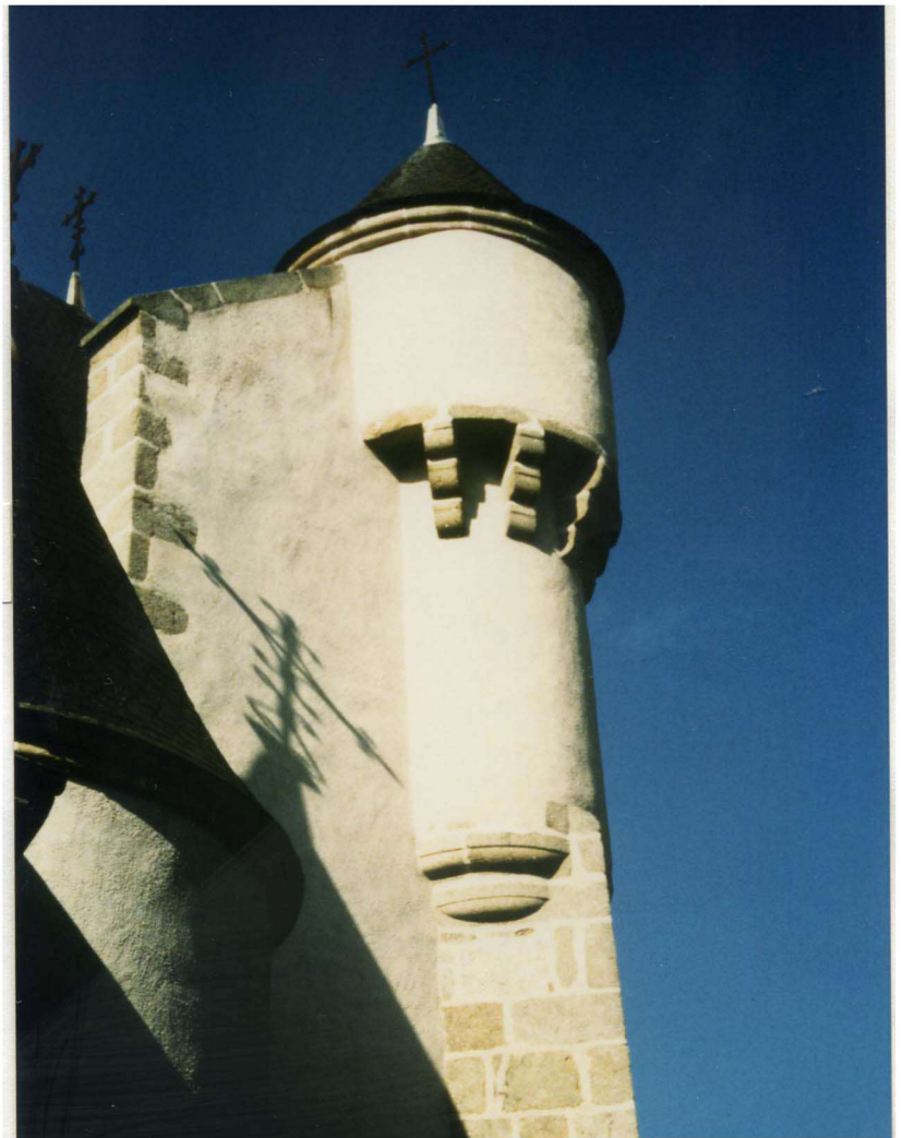
Le haut de la façade Ouest Une bretèche à machicoulis sur le chemin de ronde entre deux échauguettes à machicoulis
