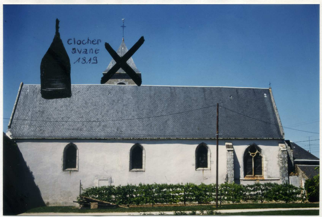
La nef restauré et l'ancien emplacement du clocher
