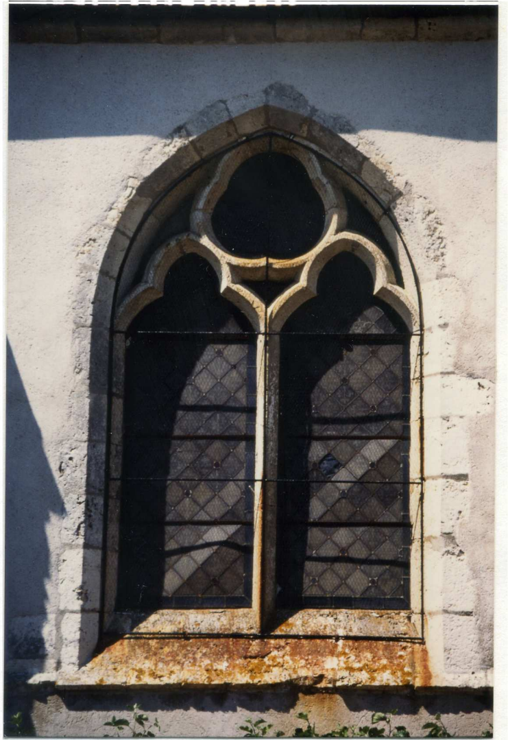
La baie fin XIII e s. du mur Sud du chœur
