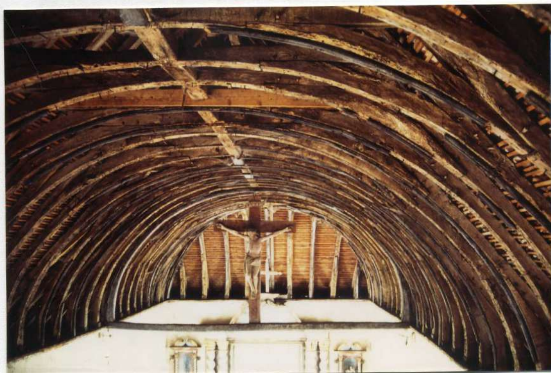
Charpente de 1654, autrefois recouverte d'un lambris peint en bleu ciel
