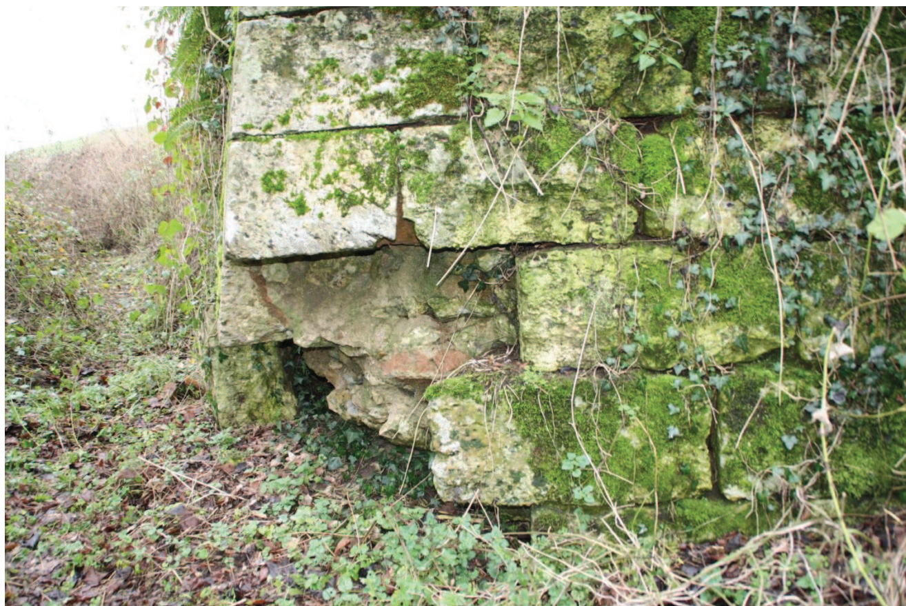
Maçonnerie au mortier rouge typiquement gallo-romaine du mur des bords de Loire
