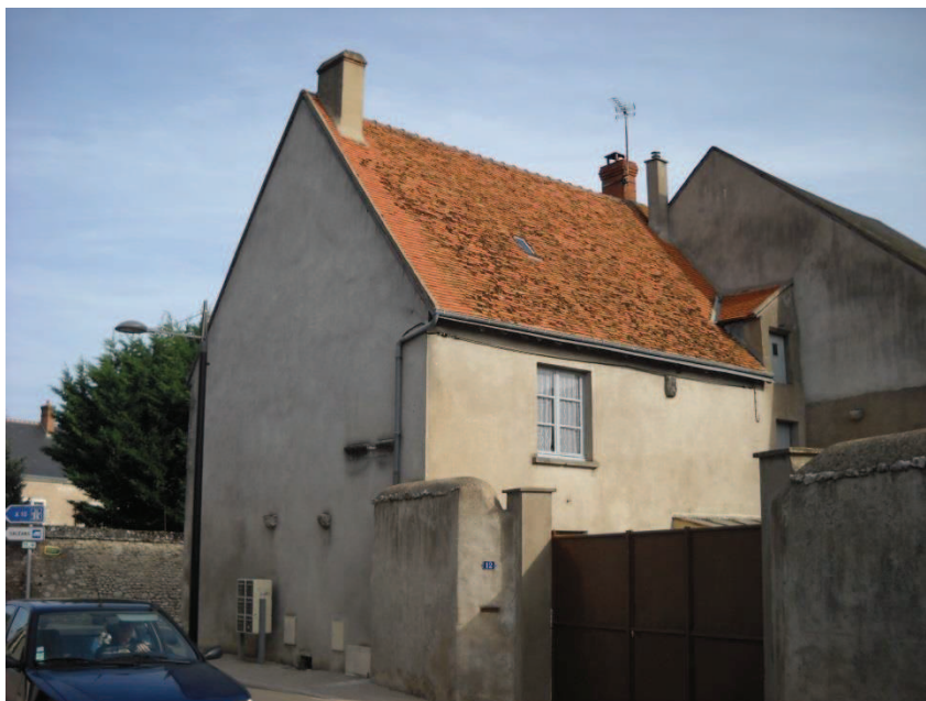
Maison de la fin du XV e siècle, rue de Chambord
