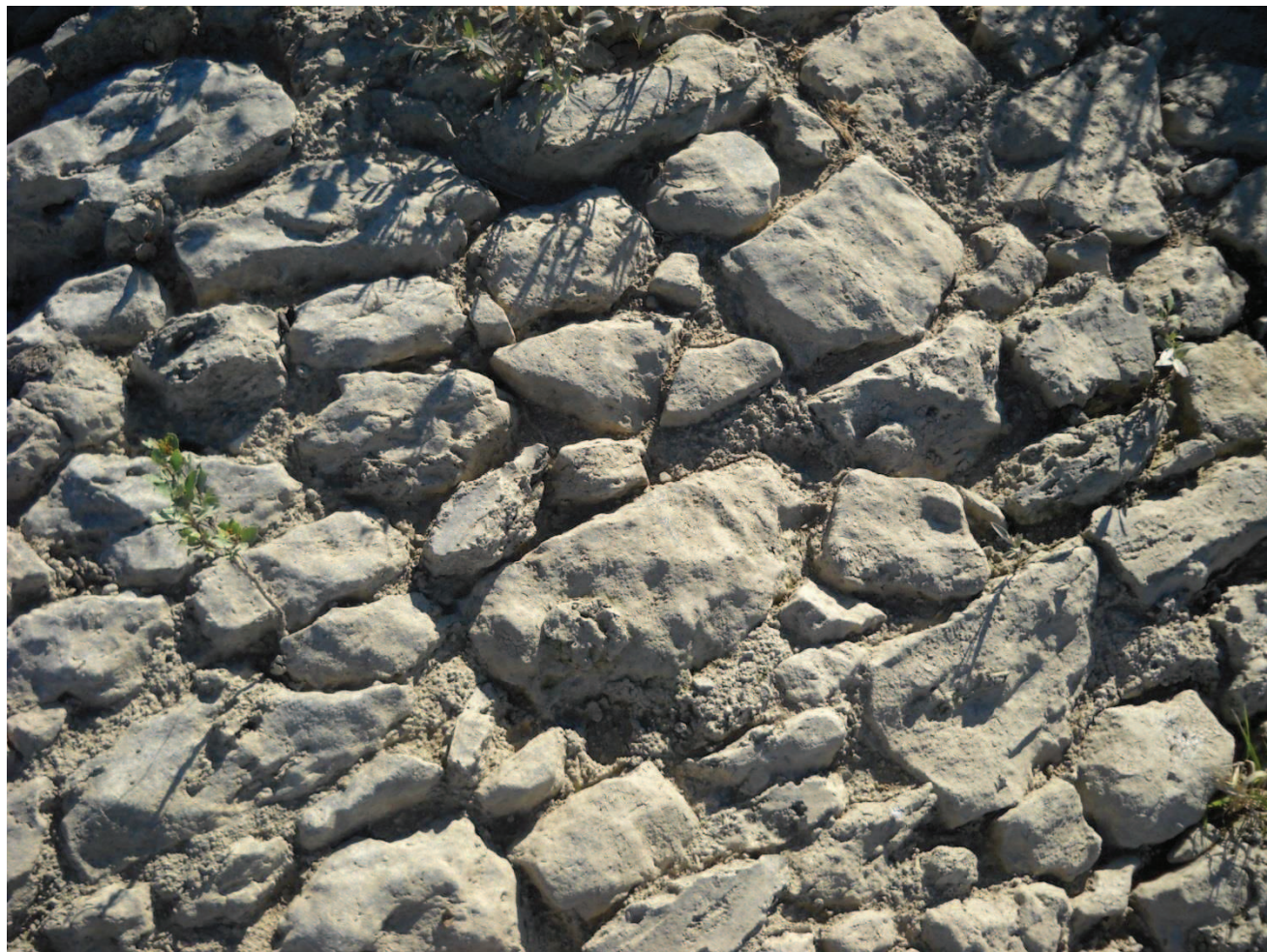
Appareillage du parement et mortier blanc à la chaux et au sable de Loire
