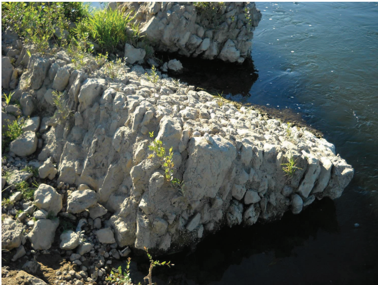
Pans du mur qui s'est écroulé au Nord de sa base
