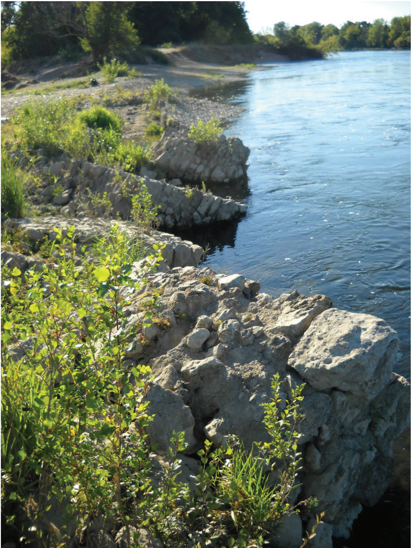
Pans du mur qui s'est écroulé au Nord de sa base.
