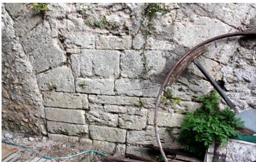
La facture de l'appareillage gallo-romain est bien visible dans la taille des pierres et dans leur agencement : réajustement en coin de certaines pierres, angle plus marqué pour les claveaux de naissance des arcs...
