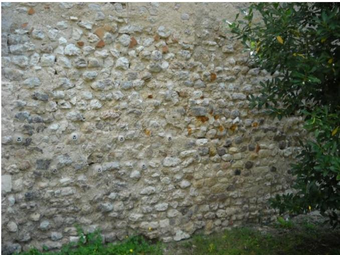
Petit appareillage de maçonnerie en moellons assisés du mur nord de la nef : fin XI<sup>e</sup> siècle.
