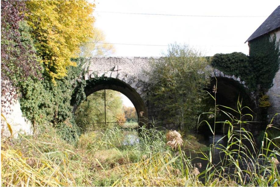
L'actuelle pont de la Chaussée-le-Comte, formé de deux grandes arches semble aussi avoir a sa base et dans sa partie ouest un appareillage gallo-romain (pierres de soutien du coffrage dépassant de l'appareillage, parfaite régularité de l'extrados des arcs, voussoirs plus long que large...). Ce pont a été très modifié à travers le temps et présente à lui seul une remarquable stratigraphie archéologique et une histoire très complexe.
